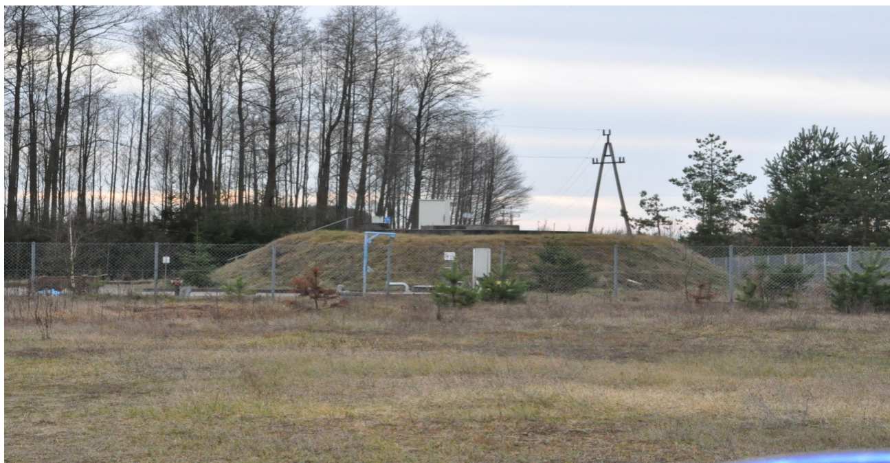
Oczyszczalnia ścieków w Dubiczach Cerkiewnych
